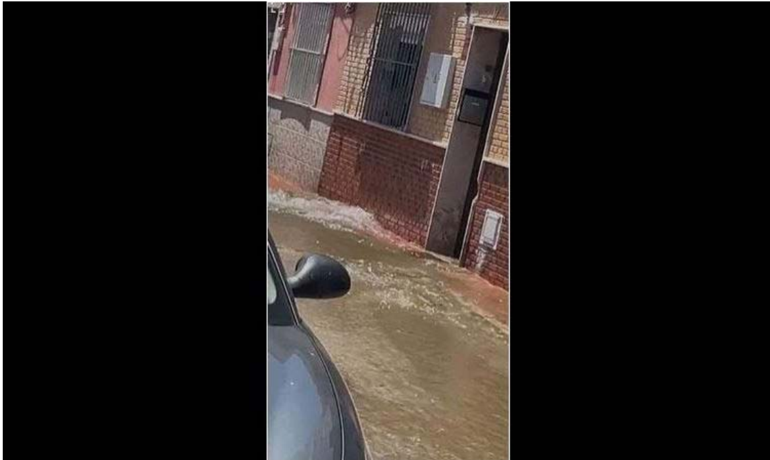
Rotura en la red de distribución de agua potable en La Línea.
